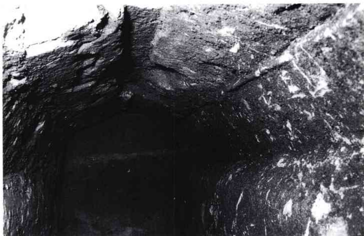
3. El Carreró, 43-45. Interior de la claveguera del cardo maximus en aquest sector.
