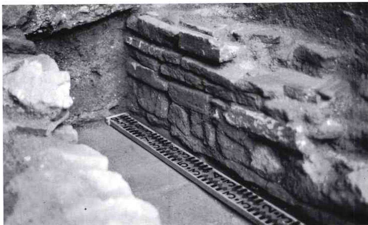
9. Carrer d'En Pujol, 51. Sector 2. Detall del mur (UE. 2017) de la claveguera domèstica romana.
