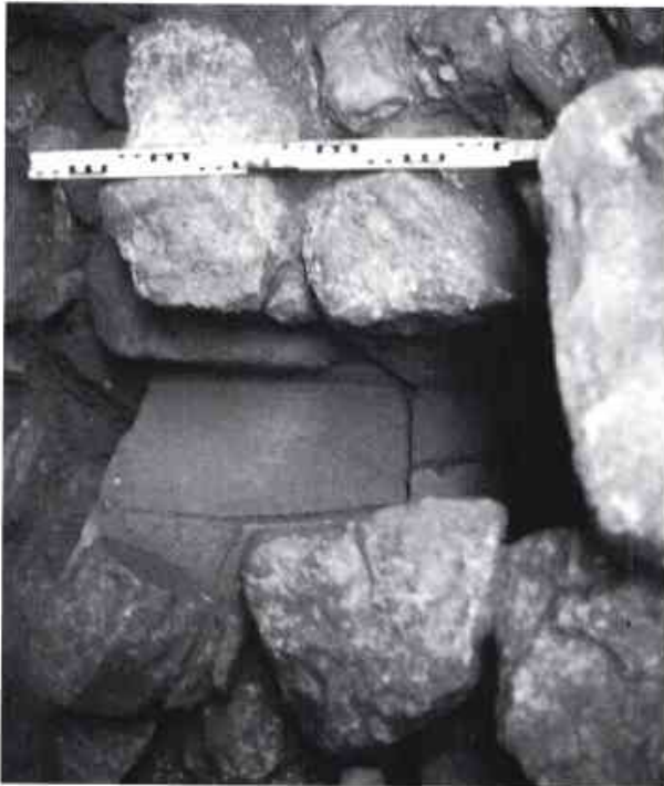
12. Carrer d'En Pujol. Claveguera secundària (UE. 39, a 41)
