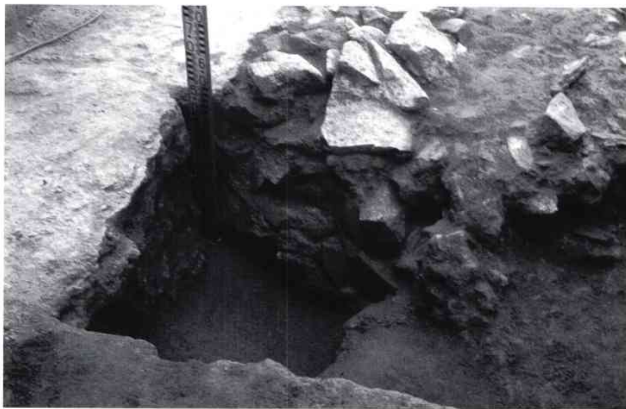
34. Carrer Barcelona, 55-57. Detall del gruix de la fonamentació UE. 3008.
