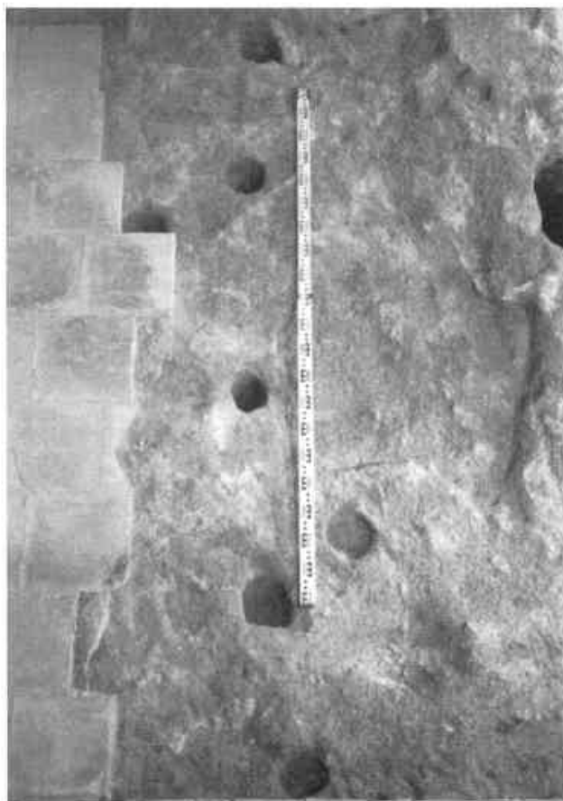
6.- Forats al sauló que corresponen a la bastida necessària per aixecar l'edifici del segle XV.
