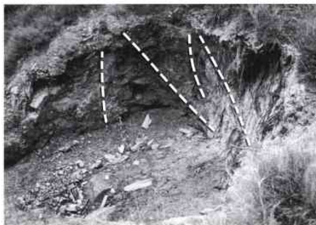
Fig. 15 Importants fractures localitzades a la part posterior o "capçalera" de la cambra, de traç paral·lel a la paret, que recentment han generat despreniment.
