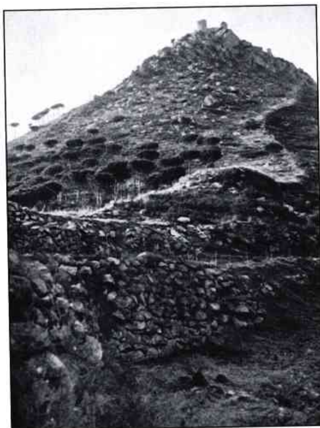
3- Vista dels treballs de neteja i desbrossament de la muralla del sector oriental, Any 1949.
