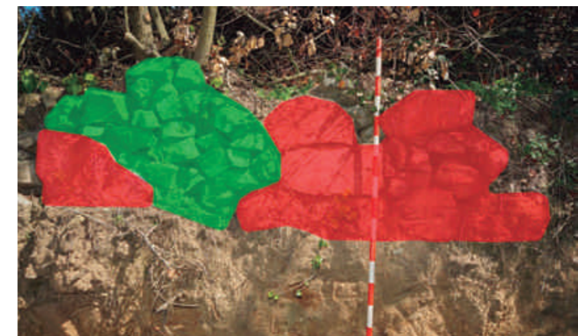
Imatge 11 / Vista del mur situat uns metres al nord, al vessant del turó (lletra E al diagrama). A sota, de color verd, les reparacions del mur. De color vermell, les pedres de mida mitjana amb la cara plana a l'exterior.
