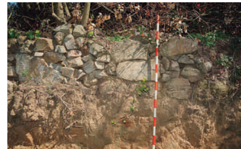
Imatge 11 / Vista del mur situat uns metres al nord, al vessant del turó (lletra E al diagrama). A sota, de color verd, les reparacions del mur. De color vermell, les pedres de mida mitjana amb la cara plana a l'exterior.
