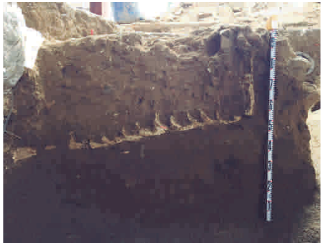
Fig. 14 / Detall del mur o muralla caiguda dintre el fossat defensiu (1472). S'observa el sistema constructiu del mur de tàpia. Font: ATICS SL
