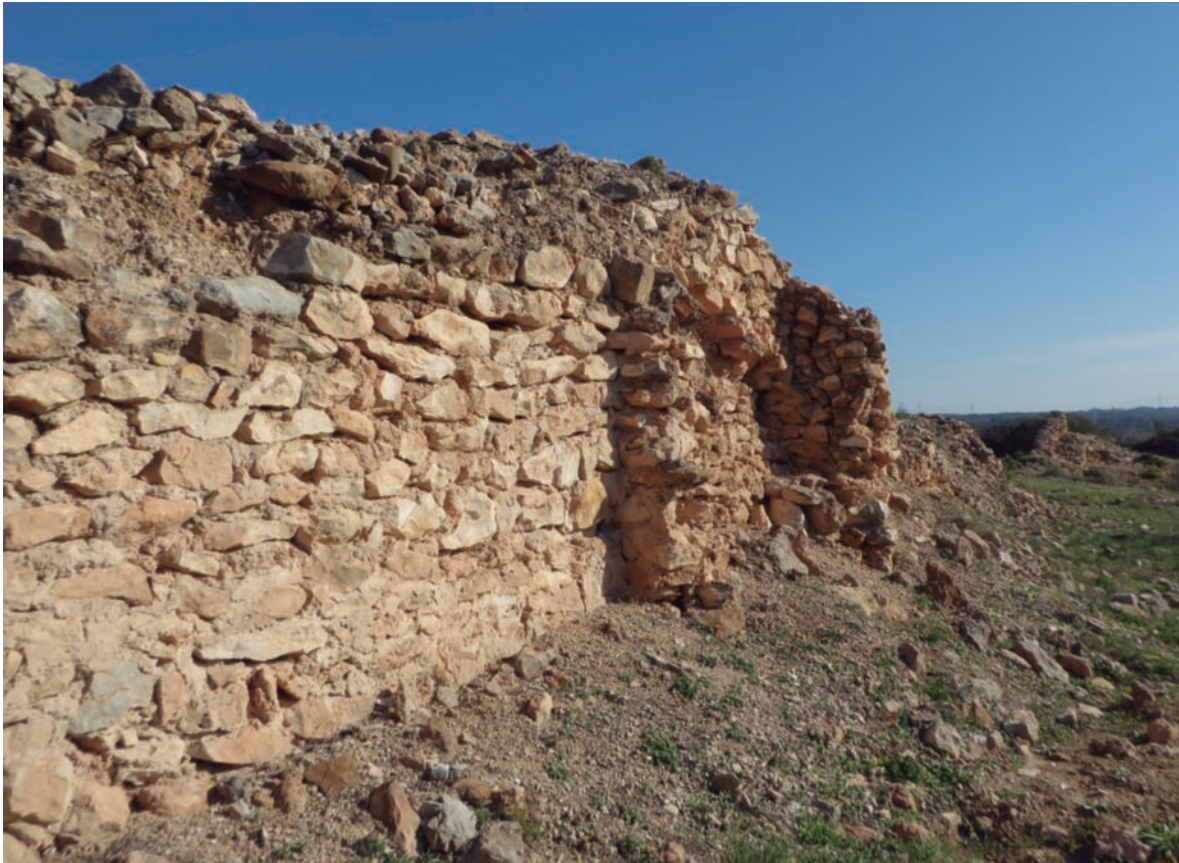
Fig. 5 / Tram de la muralla de València la Vella amb les restes d'una torre.
