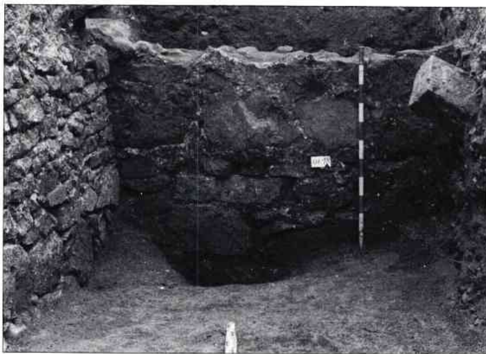
Foto 8: Alçat de la paret U.E. 18-A, assentada sobre el terreny natural. (Foto J. Pera.)
