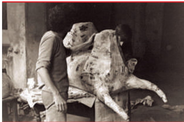
Construcció de la Momerota / Foto: Toni Canal
